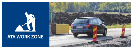
Skyltar, väg- och kantmarkering, tung avstängning och byggstaket
